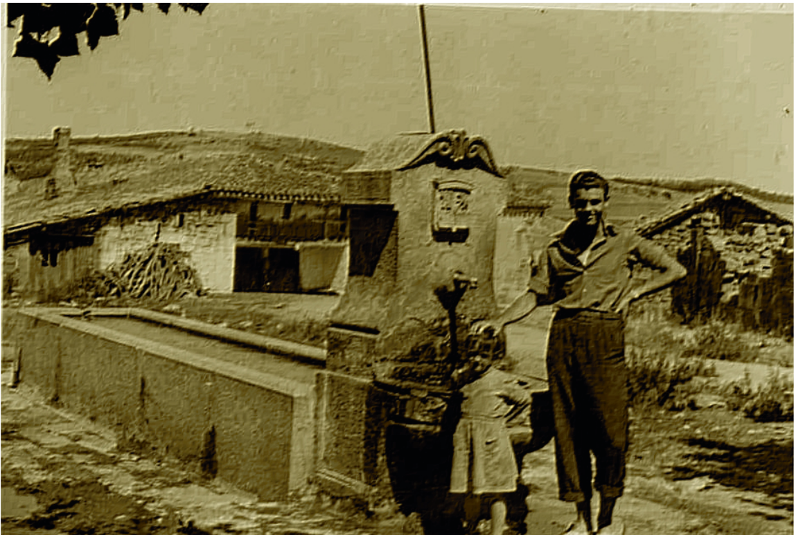
Foto desde la fuente nueva, que se construyó en 1922 al igual que la de Hontoria y Navas. Al fondo (izda.) una casa carretera de portalón, antes de las dos últimas remodelaciones. A la dcha. una ruina, sobre la que hoy se levanta la casa de Cesar. Abajo la foto actual.
